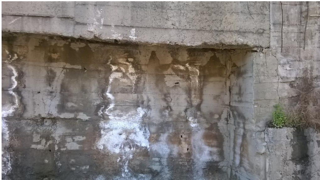
Muro di sostegno confine Est area aziendale Stato di fatto in periodo non piovoso
